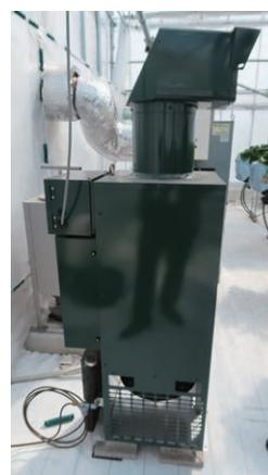
廃プラ油化燃料の燃焼によるCO<sub>2</sub>発生装置。いちごの光合成を促す
