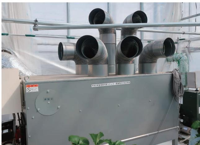
再生重油を燃料とする暖房装置をハウス内に2機設置。室温が7℃まで下がると自動的に作動する
